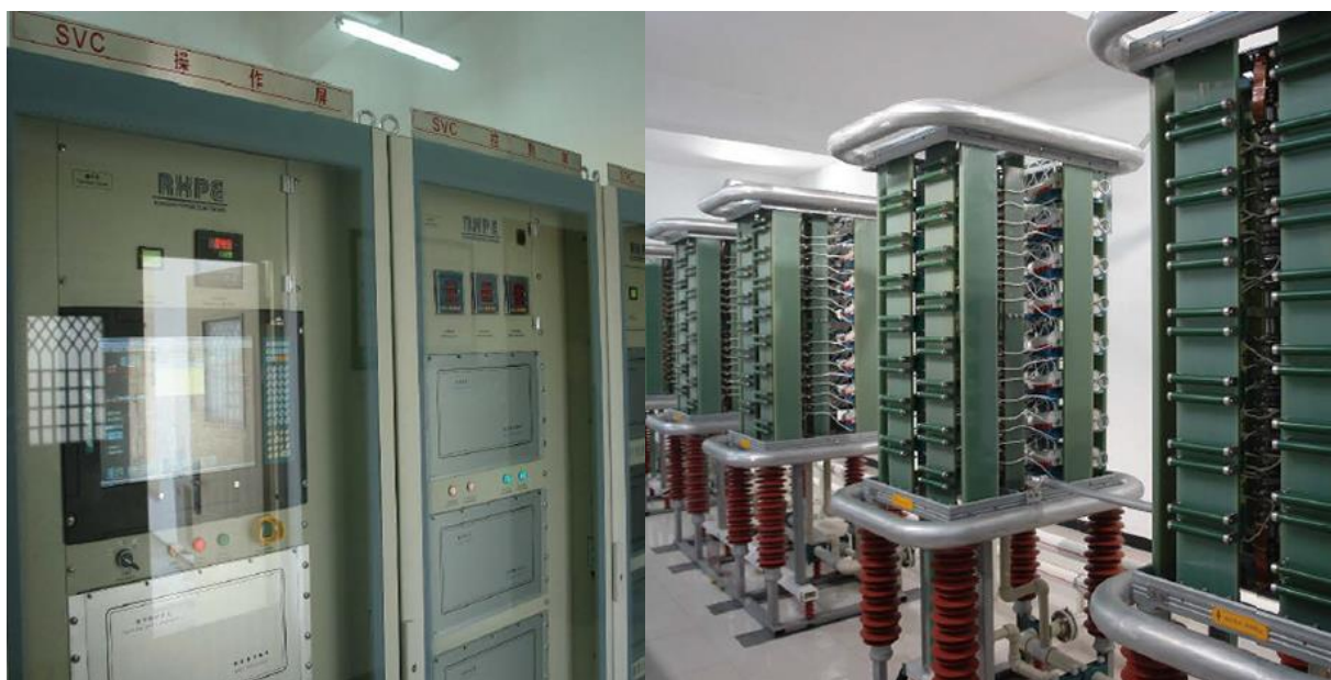
Расми 3. Намуди зоҳирии блокҳои ҚСТ 140 МВАр бо тиристорҳои 66 кВ аз ширкати RXPE
